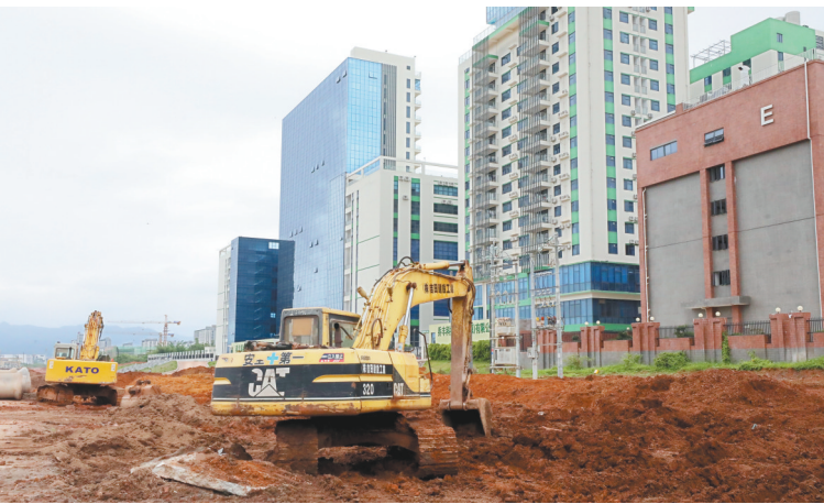
■高新大道辅道项目施工现场
