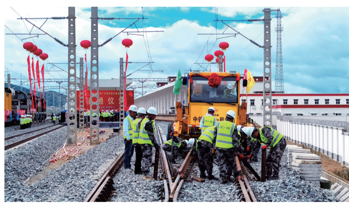
9月19日,施工人员在滇藏铁路丽江至香格里拉站铺轨。当日,在云南省迪庆藏族自治州香格里拉站施工现场,随着最后一对500米长钢轨精准落在道床上,滇藏铁路丽江至香格里拉段全线铺轨完成,为年内开通运营奠定坚实基础。丽香段开通运营后,迪庆藏族自治州将结束不通铁路的历史。
