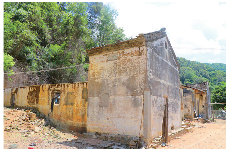
■ 曾田镇横坑村半径丘屋,是东二支队与保十三团第二次谈判旧址。
