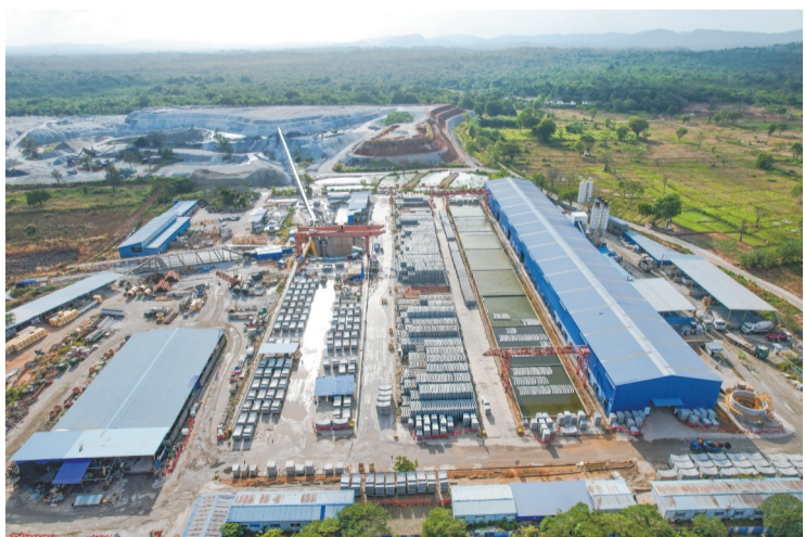
这是2026年1月19日拍摄的斯里兰卡埃勒黑勒运河引水隧洞项目施工现场(无人机照片)。 新华社发
