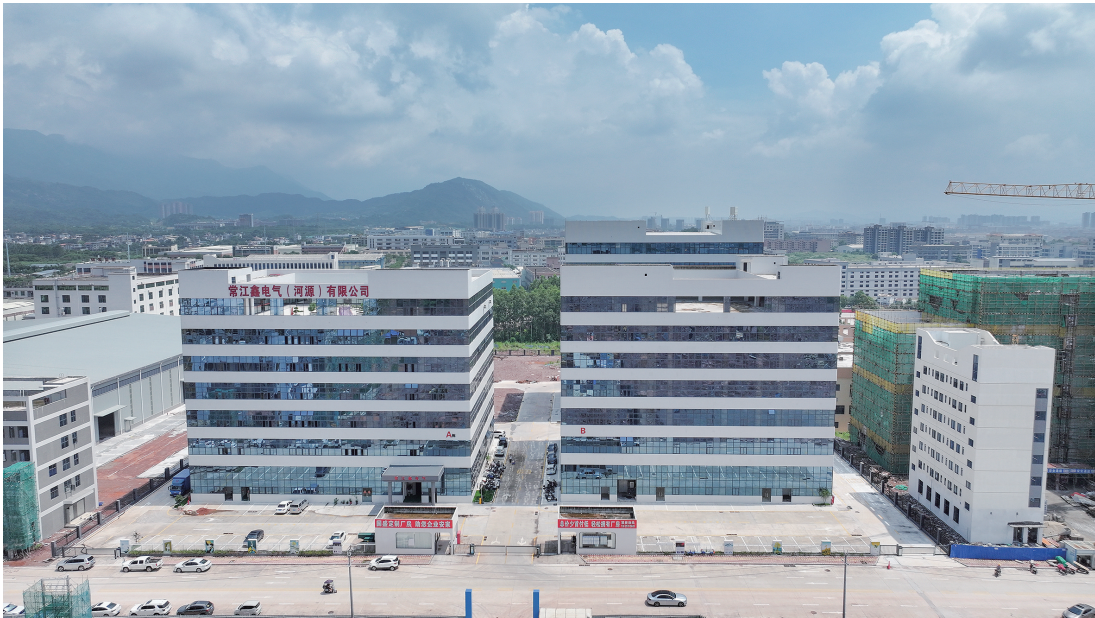
建设中的常江鑫电气(河源)有限公司厂房。该公司于去年5月21日成立,研发生产和销售多类电气相关产品,包括电子专用设备、安防设备、电力设施器材等。 本报记者 冯晓铭 摄
