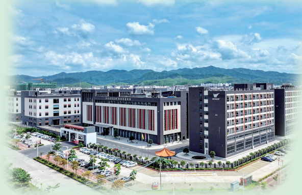
■河源市万利科技有限公司于去年竣工投产
