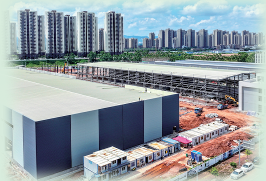
■河源林安智慧物流园项目位于盐东物流园,目前正在热火朝天建设中。
