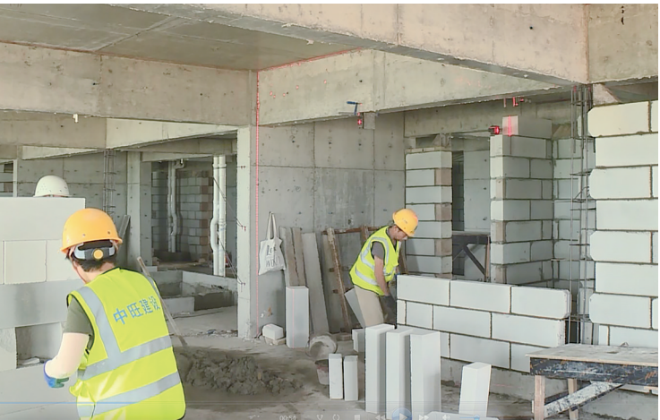
■正在建设的河源国家高新区模具城配套及模具交易市场项目 本报记者 王亚娇 摄
