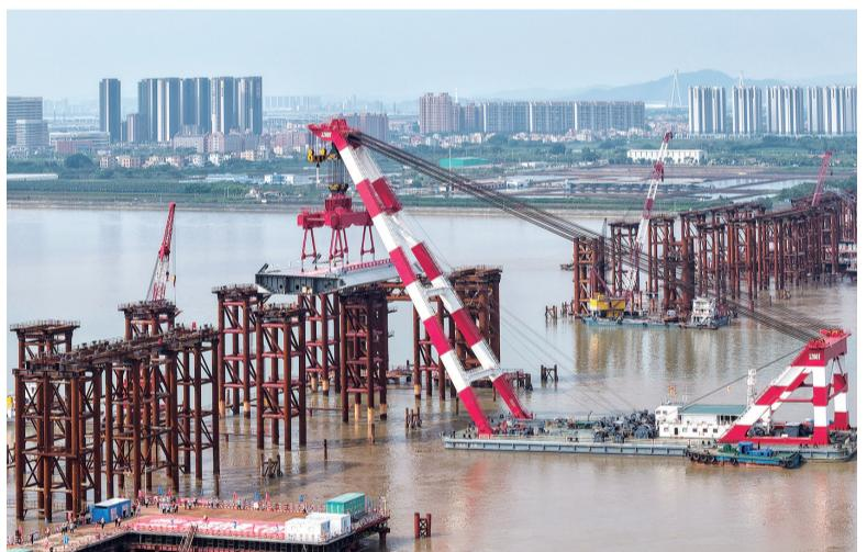
4月29日,1200吨大型浮吊将重达606吨的首节钢箱梁吊装架设到万龙大桥钢梁支架上(无人机照片)。
