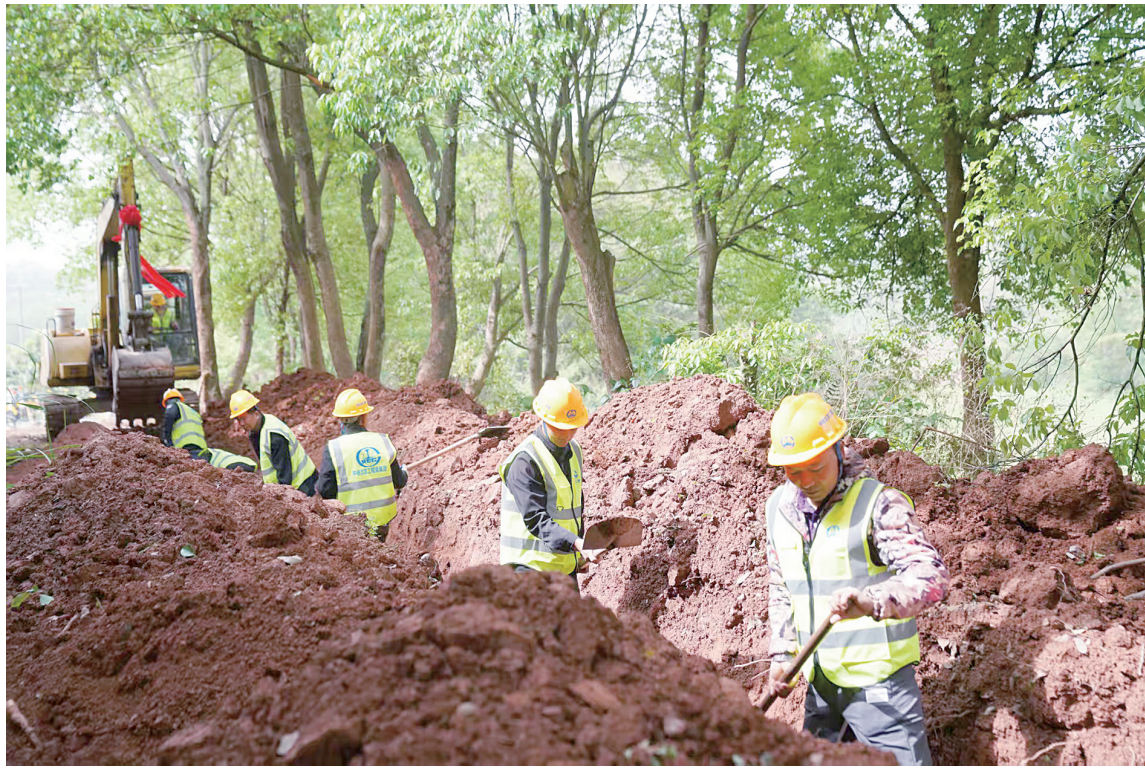
前日，东源县灯塔镇结游草村污水处理设施及污水管网工程正式动工。 本报记者 杨坚 摄
