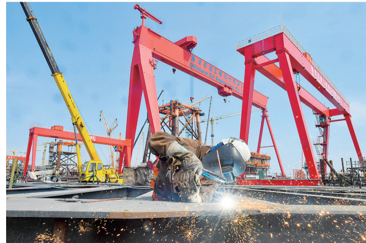
■3月30日，工人在海油工程天津智能化制造基地进行渤海油田平台钢材预制作业。时值一季度末，各地企业一片繁忙景象，工人们加紧生产兑现订单，力争超额完成任务，冲刺“开门红”。 新华社发
