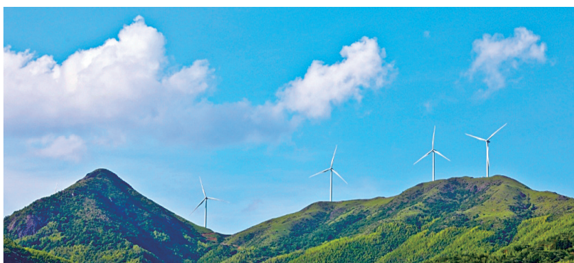
■龙川县上坪镇因地制宜,一台台风力发电机矗立在群山之巅,与连绵起伏的群山相映成趣,组成一道亮丽的风景线。冯晓铭 摄
