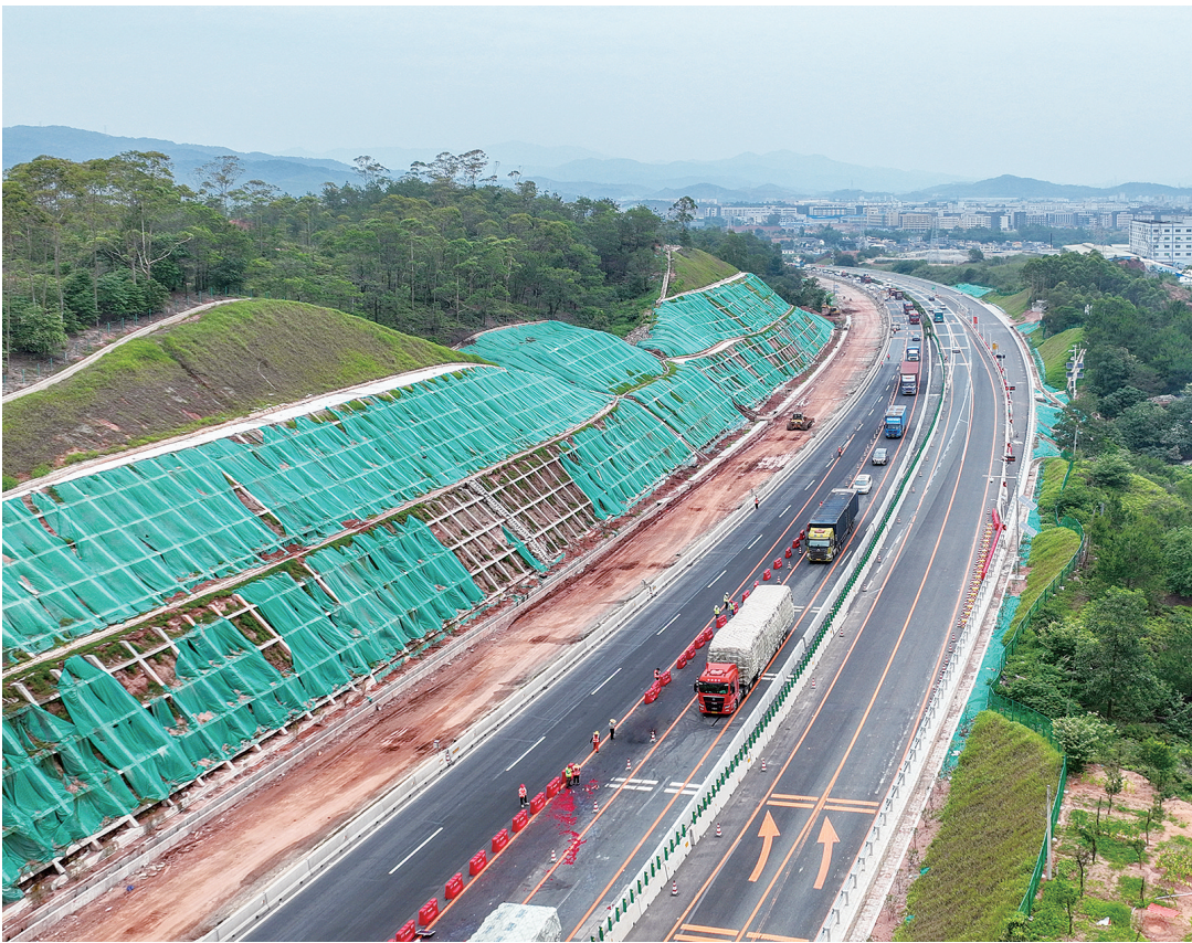
长深高速改扩建项目T1标交通转换现场 杨坚摄
