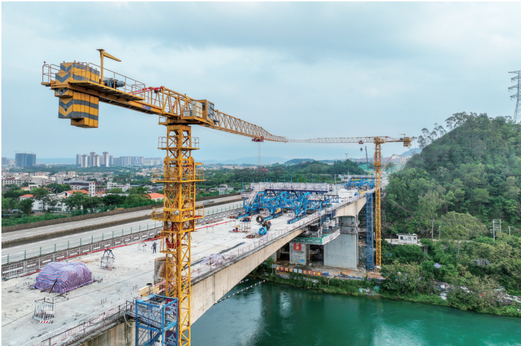
■长深高速改扩建工程T2标新丰江大桥施工现场，塔吊司机冯波和田静夫妻俩可以通过驾驶室前视窗隔江相望。 本报记者 杨坚 摄
