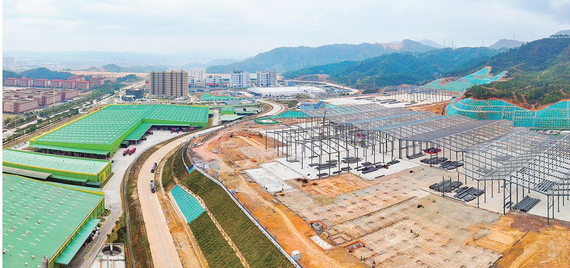
■昨日,位于水经济产业园片区的农夫山泉三期项目,施工现场一片繁忙景象。
