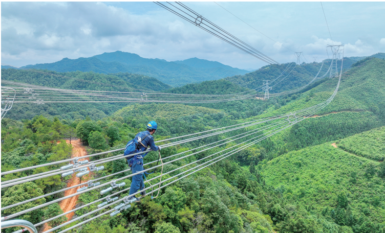
■图为粤港澳大湾区外环东段(河源段)高空走线验收现场。粤港澳大湾区500千伏外环东段工程是广东省电网“十四五”规划重点工程项目,是广东目标网架骨干网架之一。
