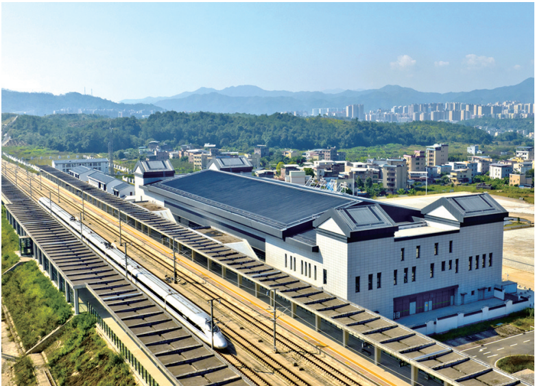
■赣深高铁和平北站
