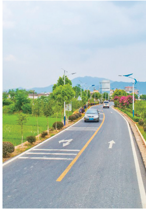
■S341线龙川鹤市段经过改造升级,路面加宽,安装了太阳能路灯,路两旁种上了绿植,成为一道靓丽的风景线。
