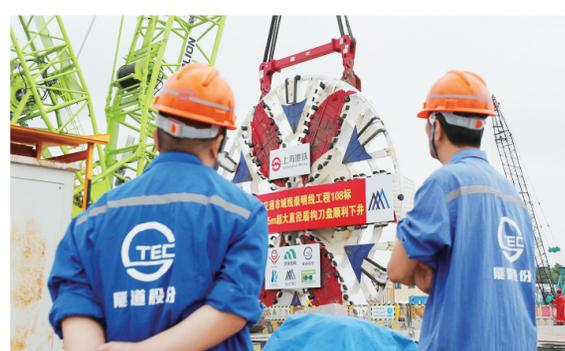
9月12日,施工人员在观看“申通号”盾构机刀盘吊装下井作业施工。当日,在位于上海长兴岛的轨道交通崇明线108标施工现场,重达308吨的“申通号”盾构机刀盘吊装下井作业顺利完成。“申通号”盾构机总长148米,当日完成吊装下井的刀盘直径13.5米,由一个中心块、6个主刀臂和6个辅刀臂焊接拼装组成。“申通号”盾构机将完成崇明线南港越江段全长7.74千米的区间隧道掘进施工,这也将是上海轨道交通穿越长江的第一条隧道。新华社发
