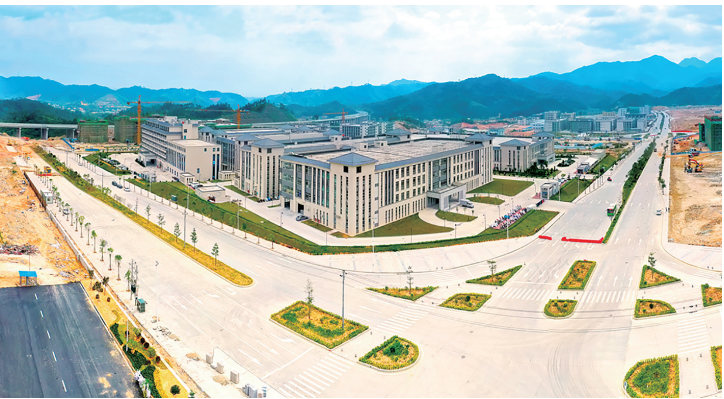
■紫城工业园首期启动区基本建成,二期基础设施建设项目全速推进。 肖斌 摄
