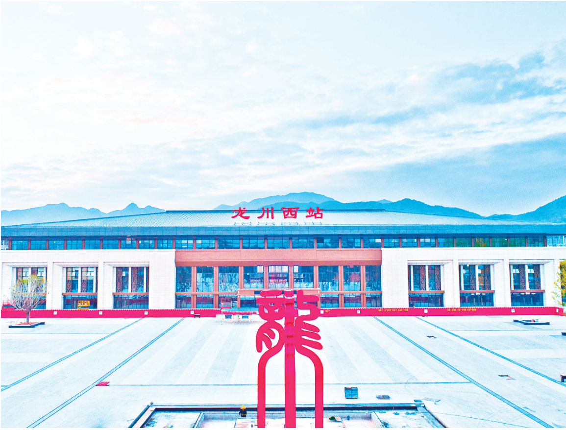
■赣深高铁龙川西站综合交通枢纽及配套工程建设进展迅速,站房室内装饰装修基本完成,进入收尾阶段。
