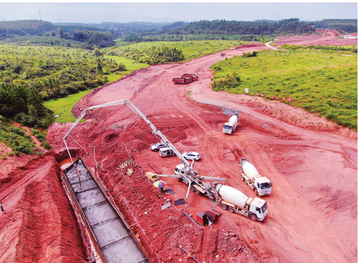
■因为粤赣高速顺天互通立交施工现场,如今的市灯塔盆地农高区处处展示着项目建设热火朝天的景象。
