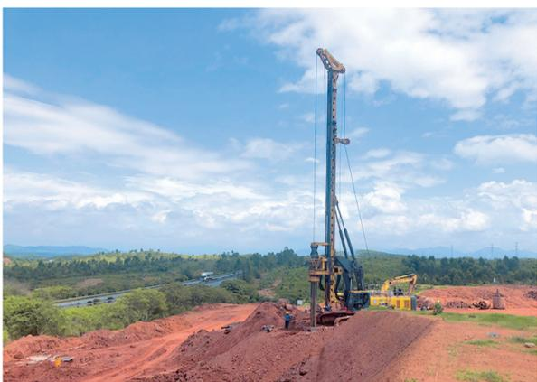
粤赣高速顺天互通立交项目，工人在A匝道跨线桥0号台桩进行基础施工。
