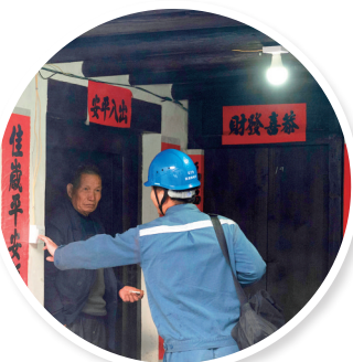
■供电所工作人员对用户内部线路进行日常巡查
