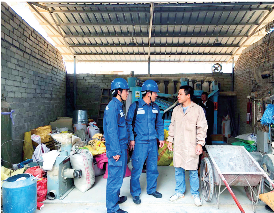
■供电所工作人员开展用电检查，叮嘱碾米厂老板安全用电。
