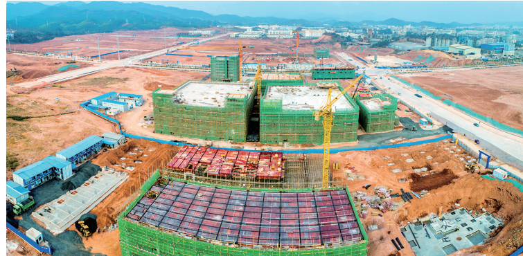
■正在建设中的盐东现代物流园
