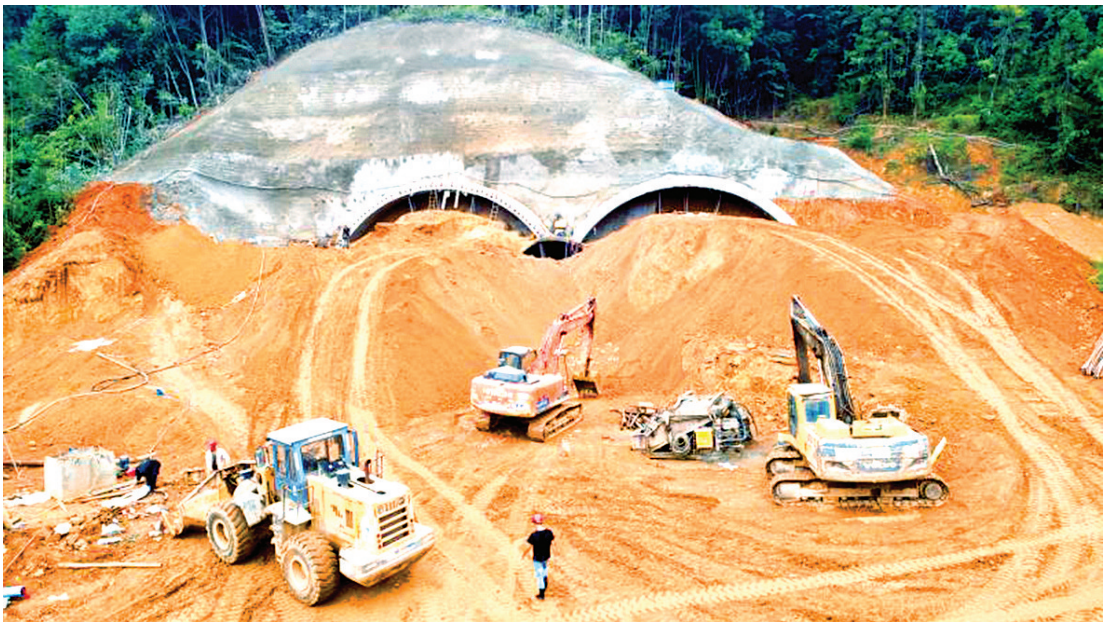
■梅龙铁路下黄田隧道斜井进洞施工,标志着梅龙铁路4标项目建设取得了新突破。 冯晓铭 摄
