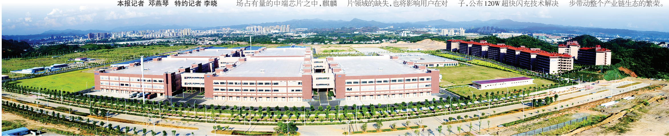
■中兴通讯河源基地 本报记者 冯晓铭 摄
