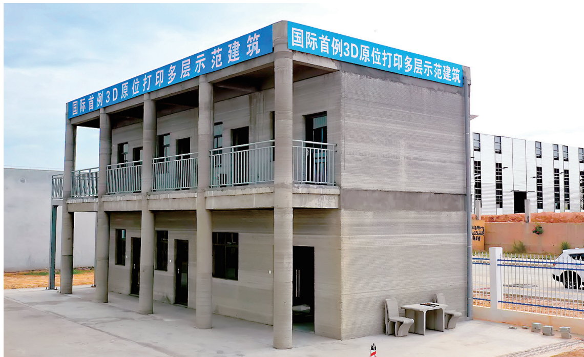
■全球首例3D原位打印的二层示范建筑 本报记者 肖斌 摄
